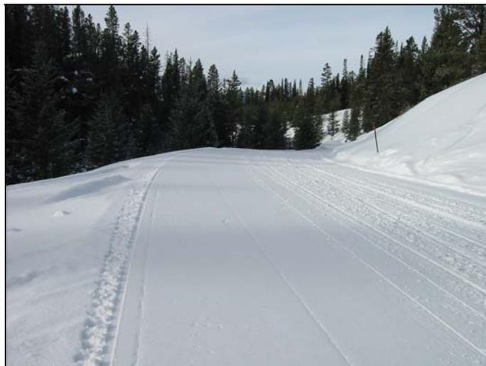
**Photo 1.8** Le damage de piste sert à former une base résistante et compactée
